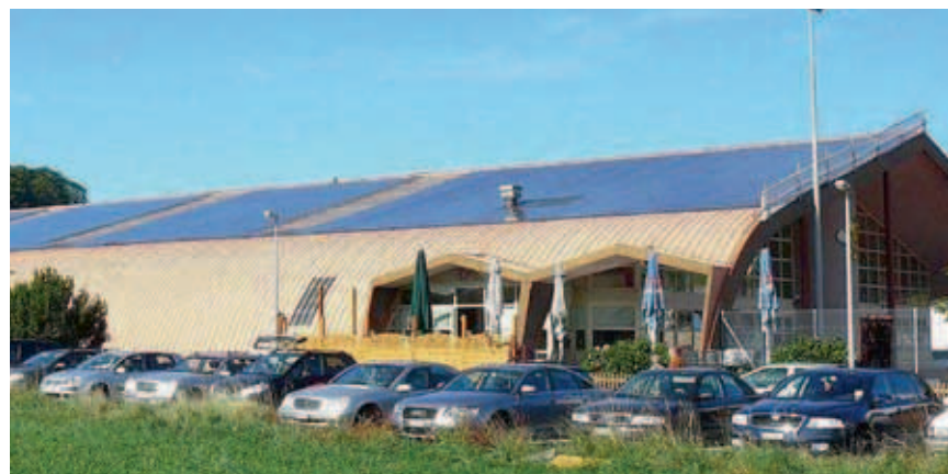
Un centre vert avec des panneaux solaires.
